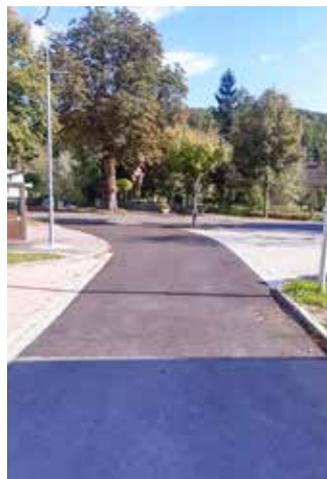
Am Vorplatz des Rüsthauses Edersgraben wurde von der Stadtgemeinde Feldbach ein neuer Regenwasserkanal mit größerer Dimension zur Ableitung der Hang- und Oberflächenwässer in den Edersgrabenbach errichtet. In weiterer Folge wurden die Pflasterflächen des Vorplatzes und der asphaltierte Zufahrtsbereich fertiggestellt.
