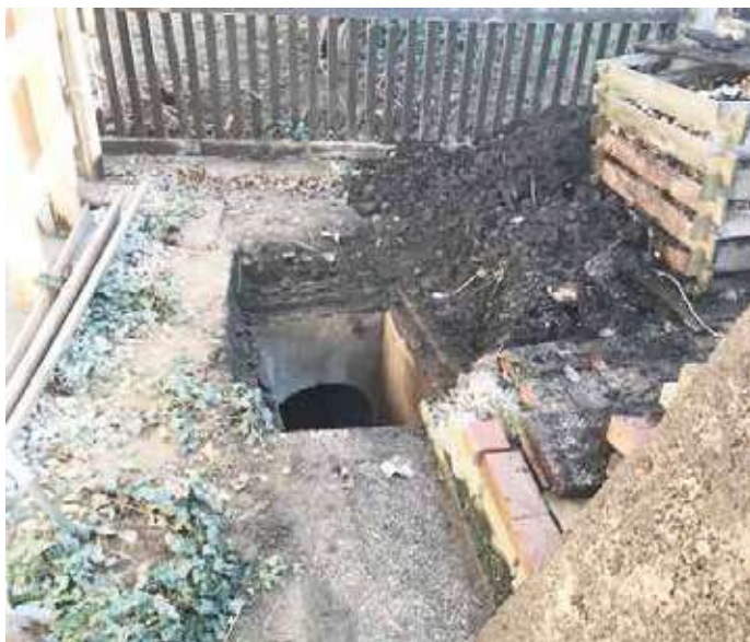
Viele Schachtabdeckungen mussten erst freigelegt werden.
