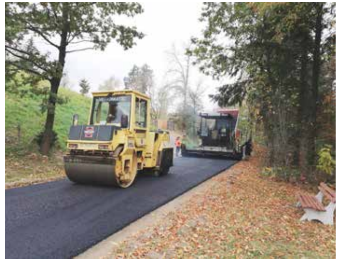
Großflächige Straßensanierung „Kulmbergweg“
