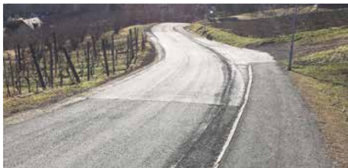
Abschluss der Sanierung „Rutschung Siedlung Schulstraße“
